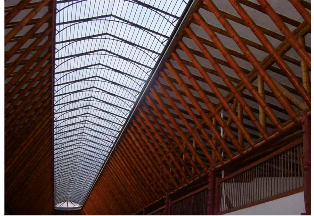
**Figura 2.65.** Vista interna de la edificación del Ministerio del Medio Ambiente, Pereira, Colombia, construido en gran parte con bambú guadua (Zhu Zhaohua).
