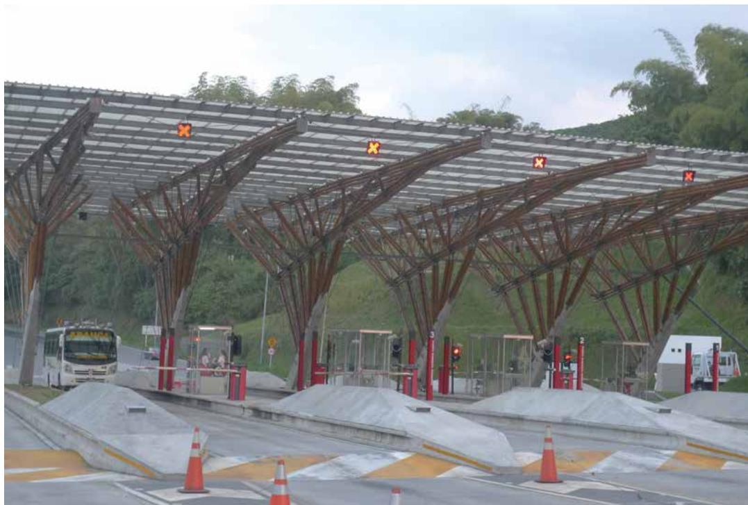
**Figura 3.97.** Estación de peaje construida con guadua sobre la autopista del Café en Colombia (Zhu Zhaohua).
