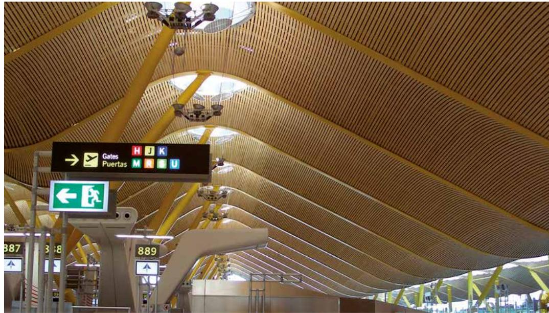
**Figura 3.123.** Aeropuerto Internacional de Barajas en Madrid, España, con el cielo raso hecho de placas multicapas enchapadas de bambú Moso (foto de Dasson).
